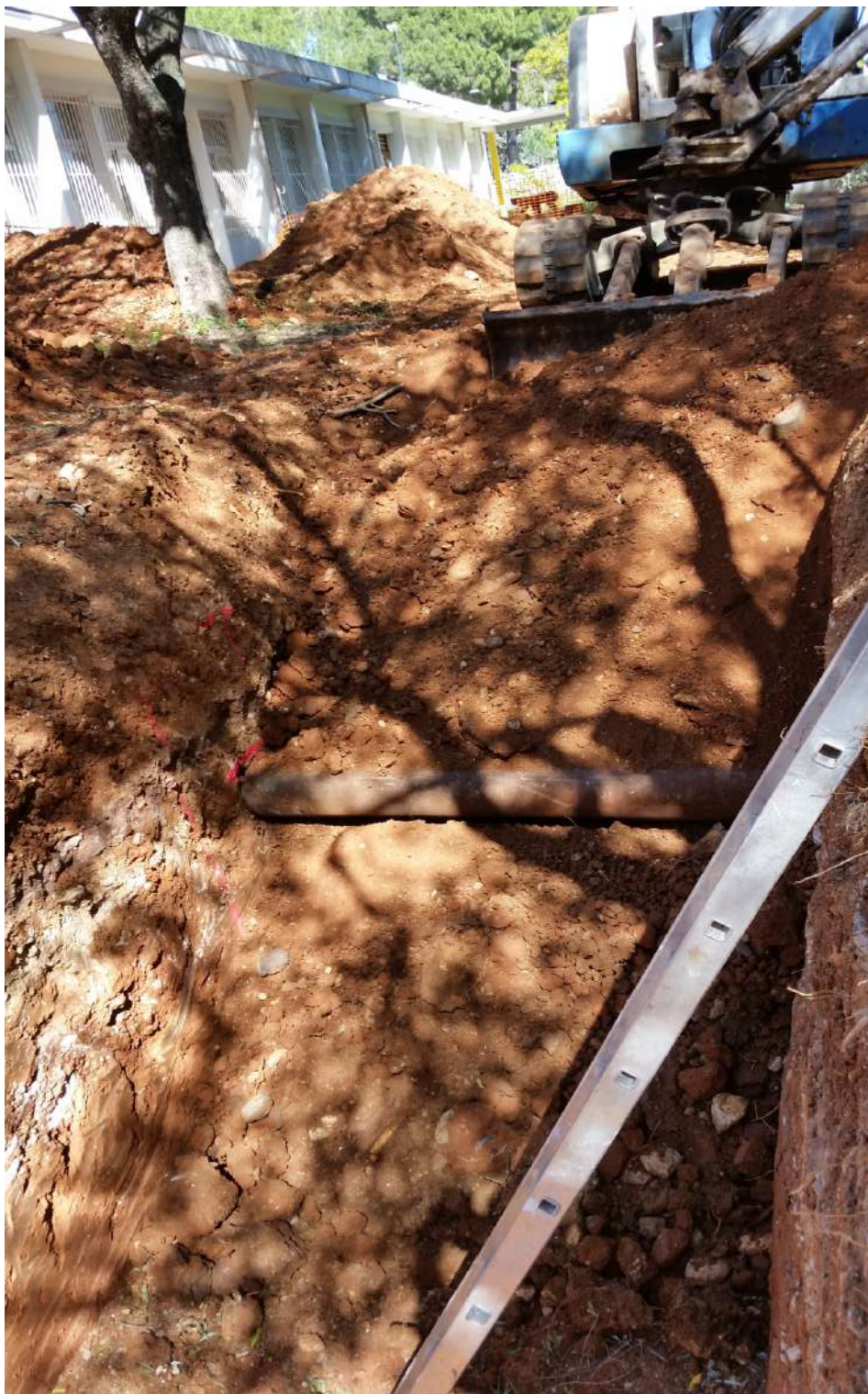
# 1 buse gros diamètre en béton laissée vide (simulation d'une cavité)
